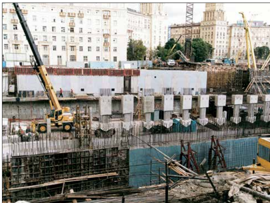
Изградња тунела испод моста „Гагарин“, Москва
